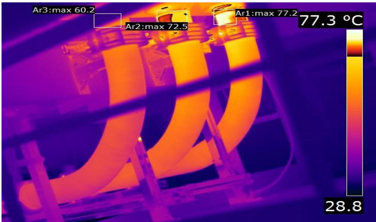
Рис. 3. Термограмма вертикального токопровода напряжением 10 кВ турбогенератора № 2
