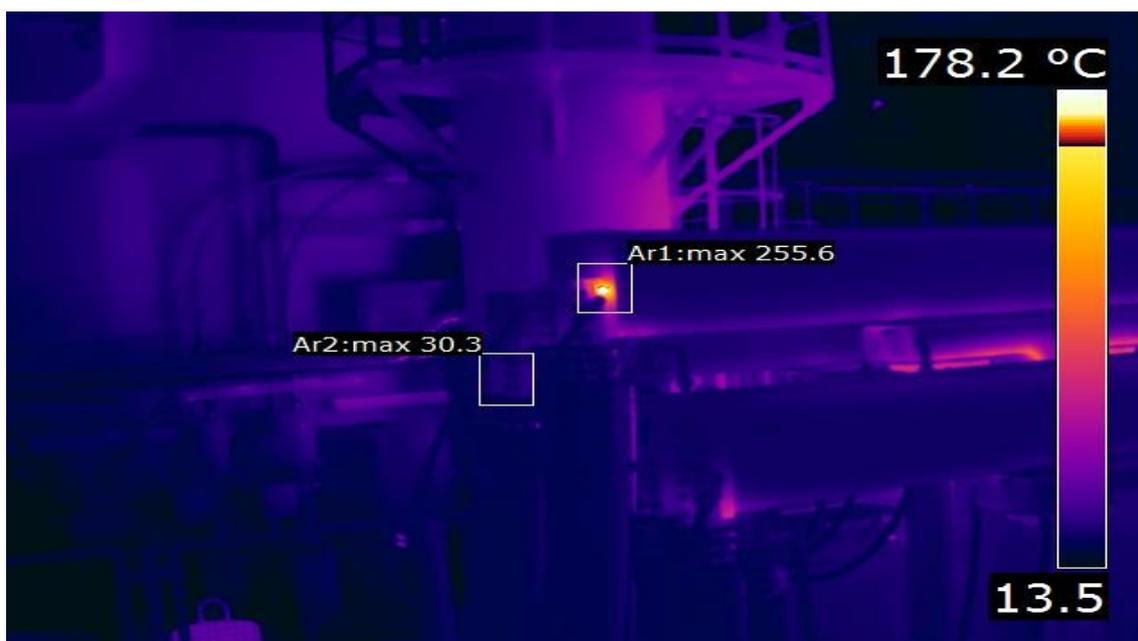
Рис. 1. Термограмма гибкого водоохлаждаемого токопровода 0,4 кВ
