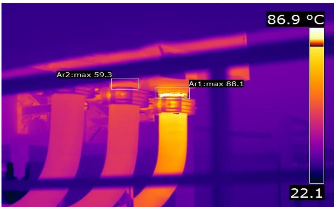
Рис. 2. Термограмма вертикального токопровода напряжением 10 кВ турбогенератора № 1
